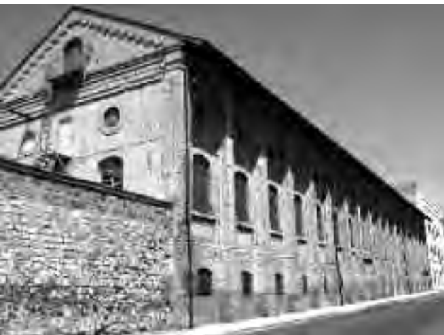
Fig. 18 - Le officine dell'acido nitrico prospicienti corso Trieste
