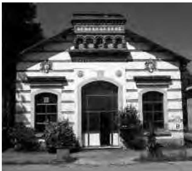
Fig. 23 - L'ex "edificio dell'orologio"
