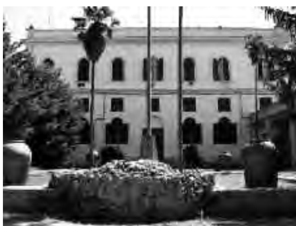
Fig. 22 - Il fronte interno degli uffici oggi
