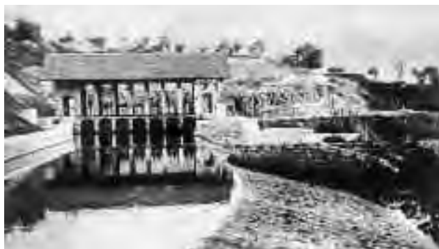
Fig. 8 - L'edificio delle paratoie di presa come appariva agli inizi del Novecento
