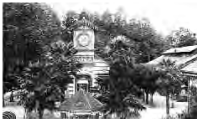
Fig. 31 - L'edificio dell'orologio in una foto d'epoca
